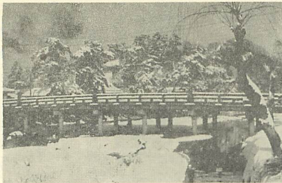
図114 津山宮川大橋（大正年間写）
