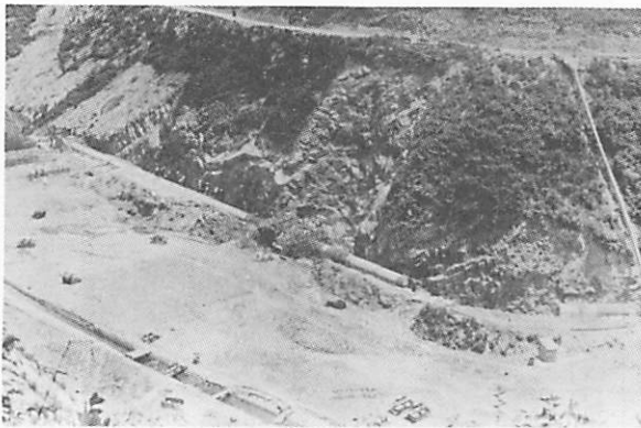
図51 工事中の昭和池（昭和池水利組合蔵）
