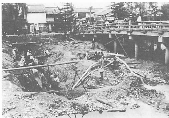
図16 上水道配水管工事 一大橋上手一 (津山市水道局蔵)
