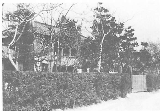
図90 南新座の幼稚園 (江見写真館撮影)
