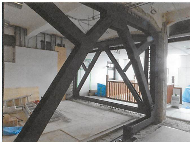
補強用の鉄骨が入っています
