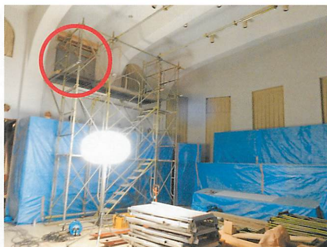
天井付近の窓を塞ぎます (赤丸で囲んだ箇所)
