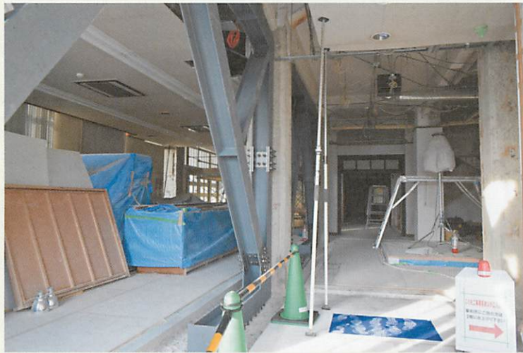
1階東側通用口から事務室
