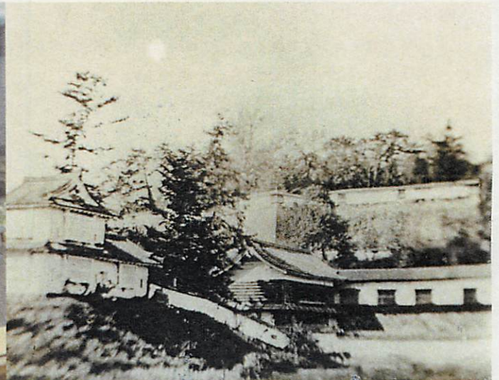
古写真B：以前から確認されていたもの。古写真Aの左側が写る
